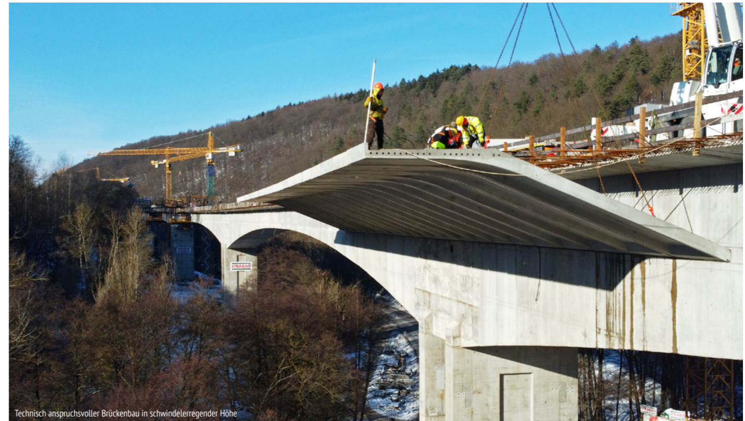
Technisch anspruchsvoller Brückenbau in schwindelerregender Höhe
