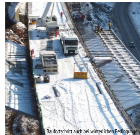
Baufortschritt auch bei winterlichen Bedingungen
