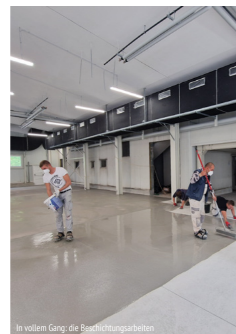
In vollem Gang: die Beschichtungsarbeiten
