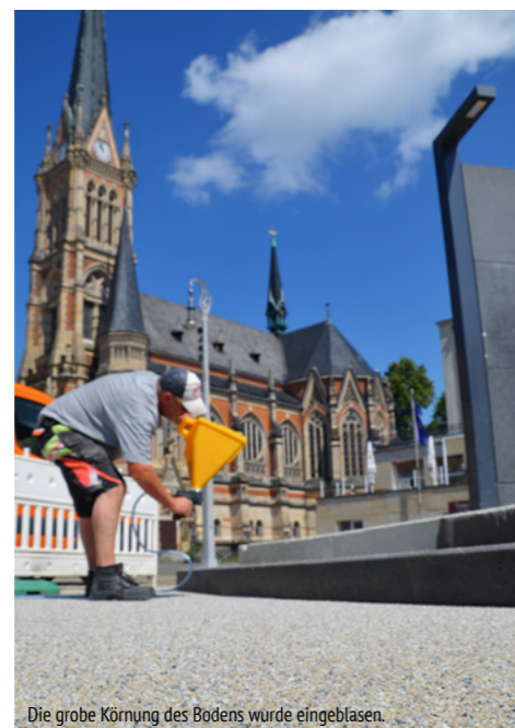
Die grobe Körnung des Bodens wurde eingeblasen.
